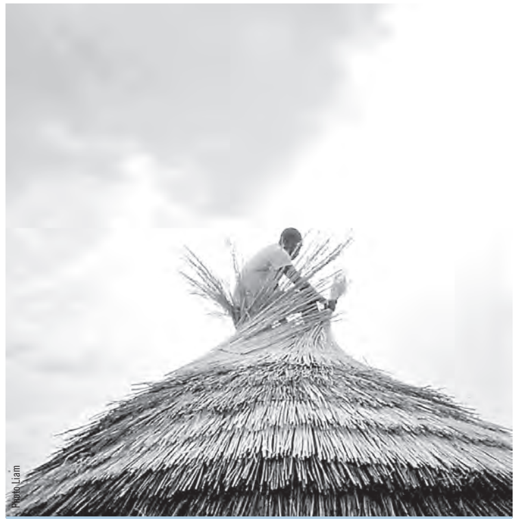
Au Burkina Faso, fabrication d'un toit.
